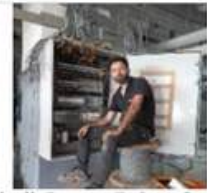
Elektrik Panosu Bakım Onarım
