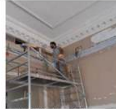
Priz Tesisatı Yapımı
