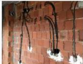
Elektrik Tesisat Kurulumu
