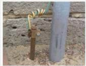
Topraklama Tesisatı Çekimi
