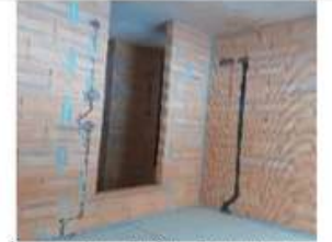
İnşaat Elektrik İşleri Ve Tadilatı Yapımı
