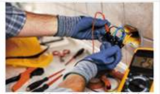
Topraklama Tesisatı Çekimi
